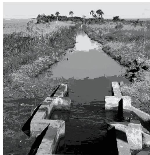
**Foto 04** Construção de drenagem para captação da água para ser utilizada na irrigação. Distrito de Santo Antônio do Rio Verde Sudeste Goiano. (Foto do autor, 2005).
